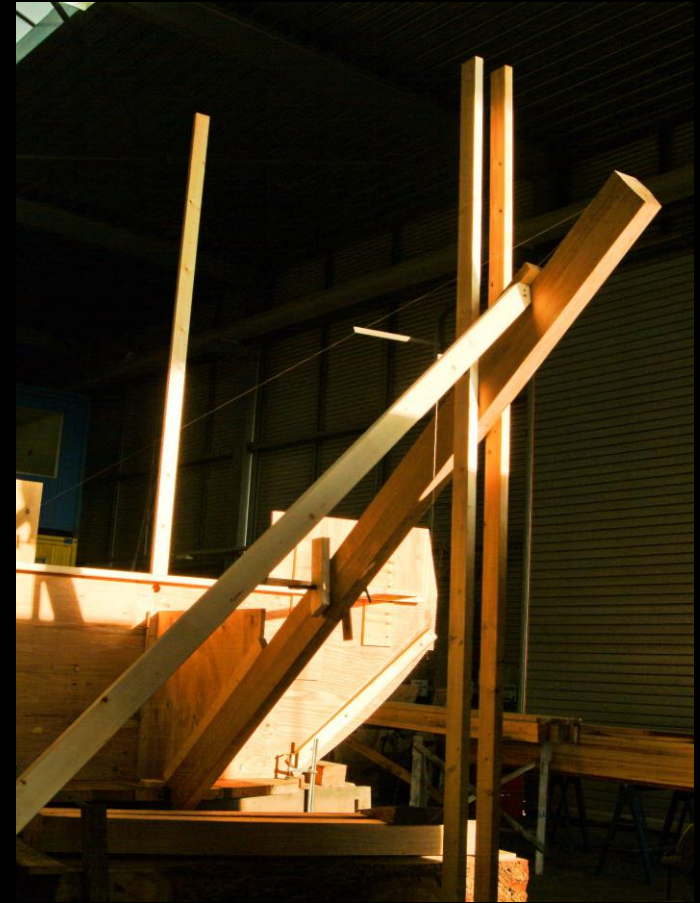
De voorstevens sluit het schip vooraan af
